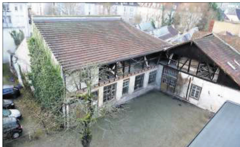
Die ehemalige Schreinerei, bevor Familie Fritz die Gebäude sanierte.
